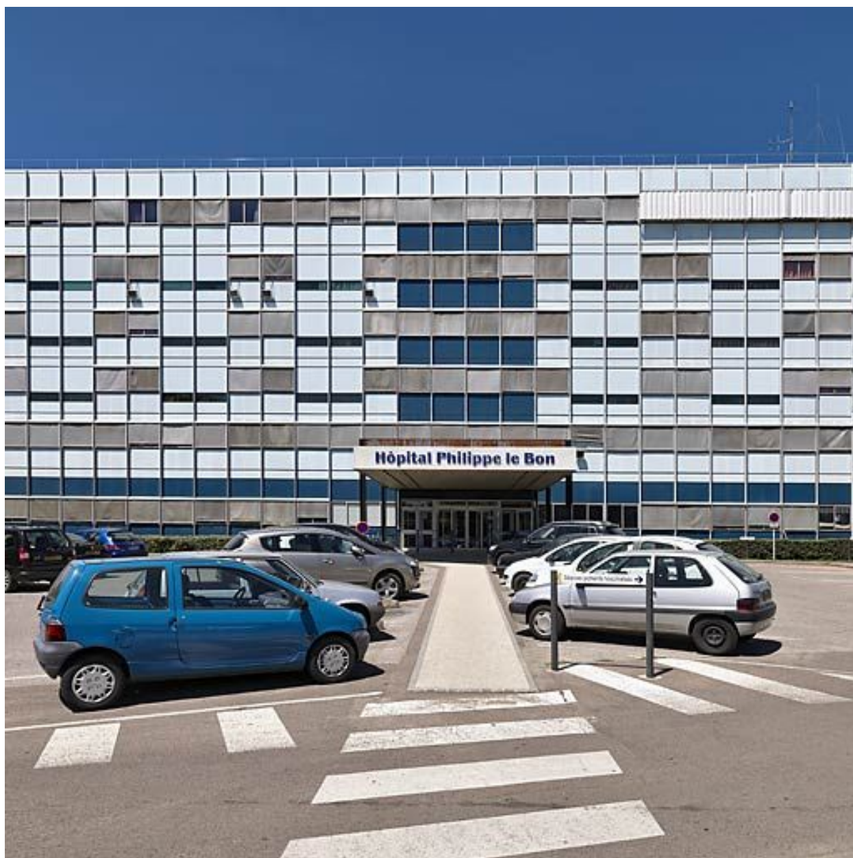
Bâtiment principal, partie centrale de la façade.
