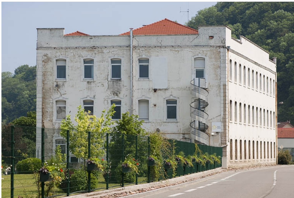
Immeuble de bureaux. Vue depuis le sud.
