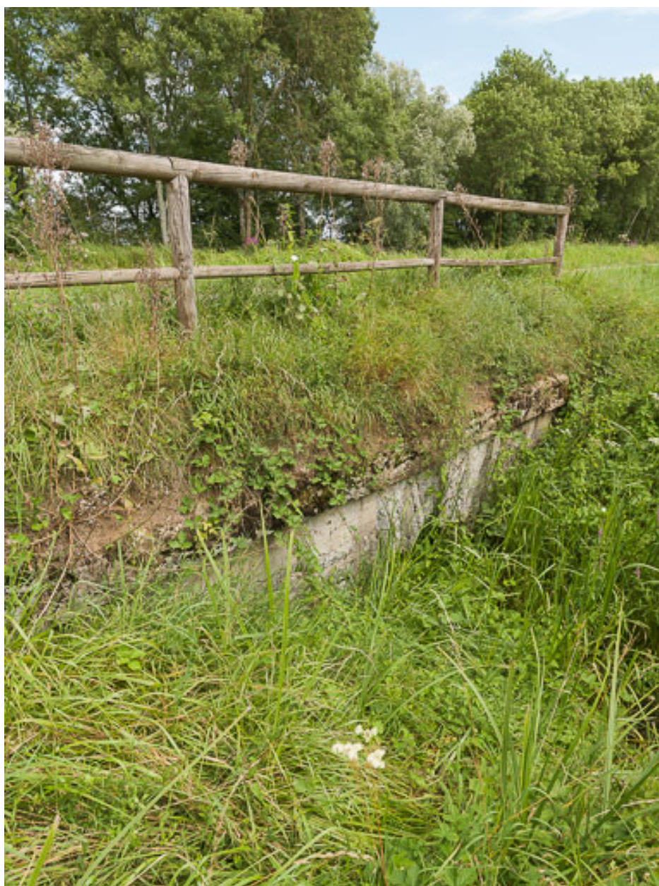
Vue de l'aqueduc.
