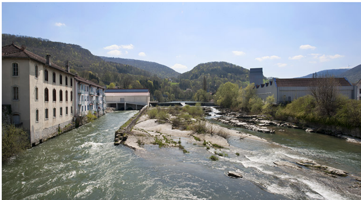
Vue d'ensemble depuis le pont.
