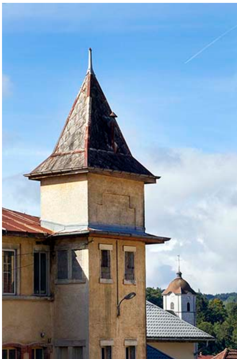
Usine, façade postérieure : tour occidentale (vue rapprochée).
