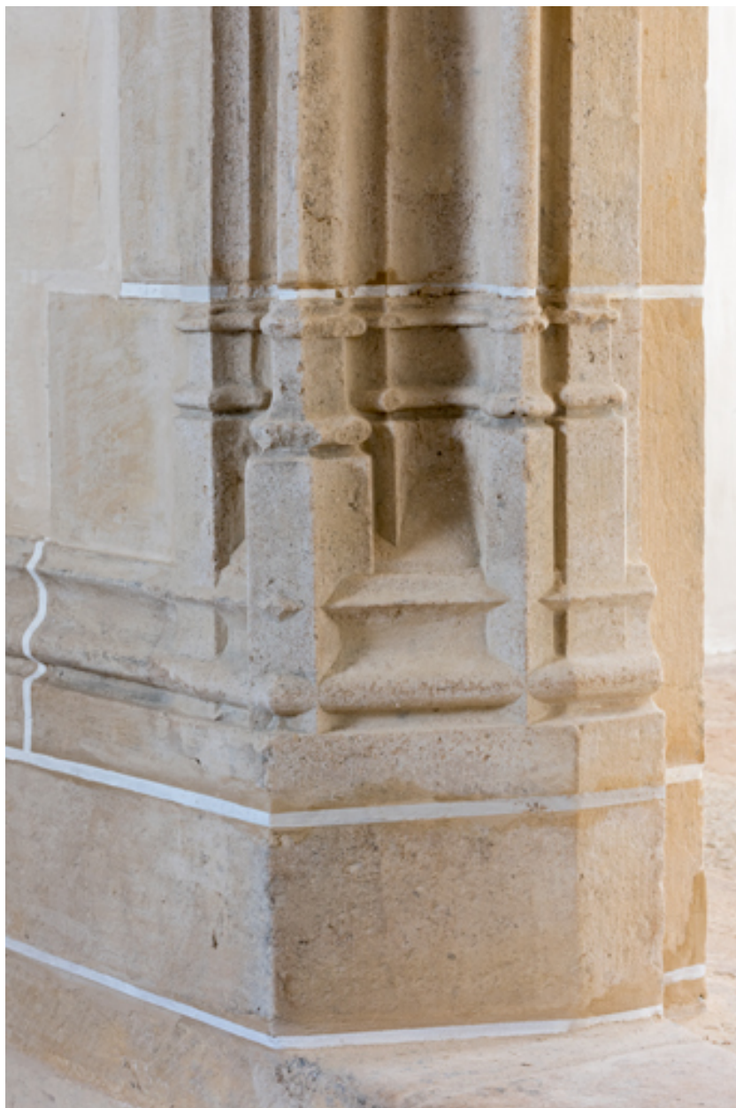
Détail : piédroit, partie inférieure.
