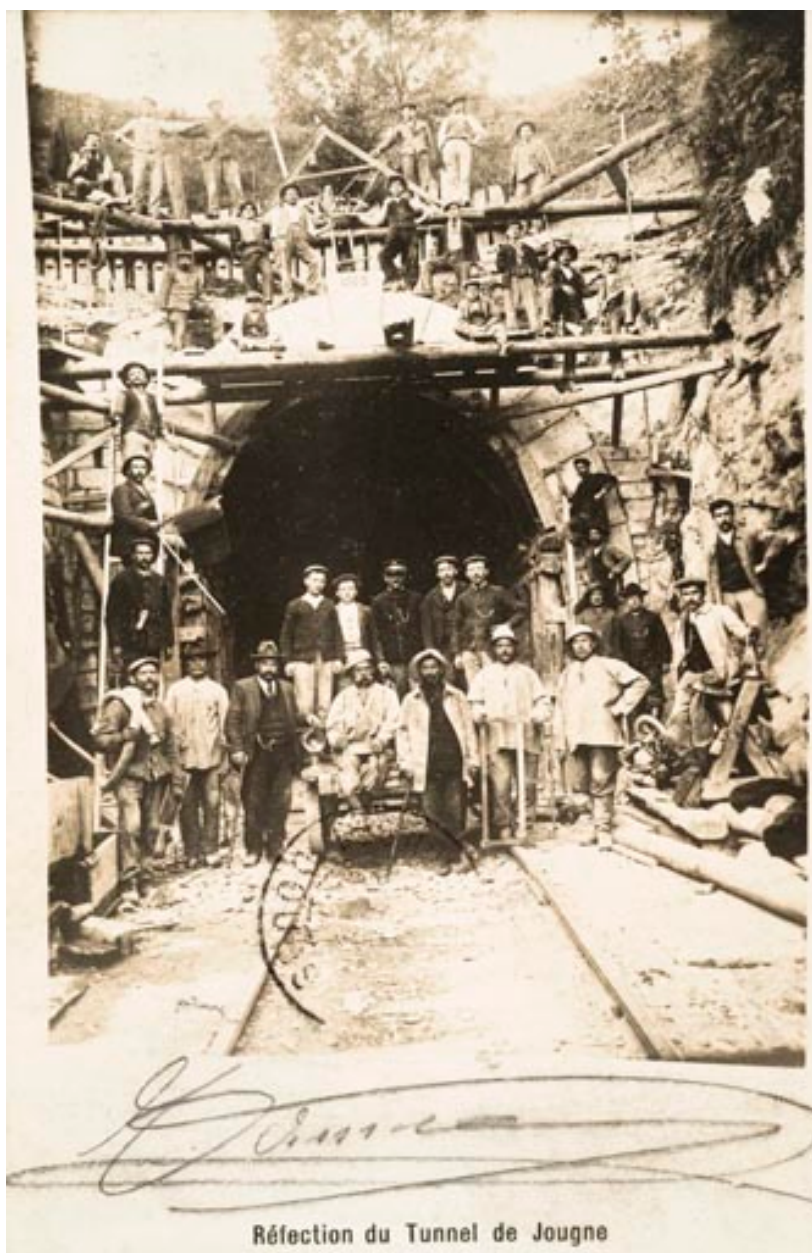
Réfection du tunnel de Jougne, 1909.
