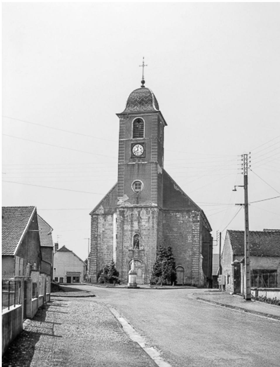
Façade antérieure avec tour-clocher.
