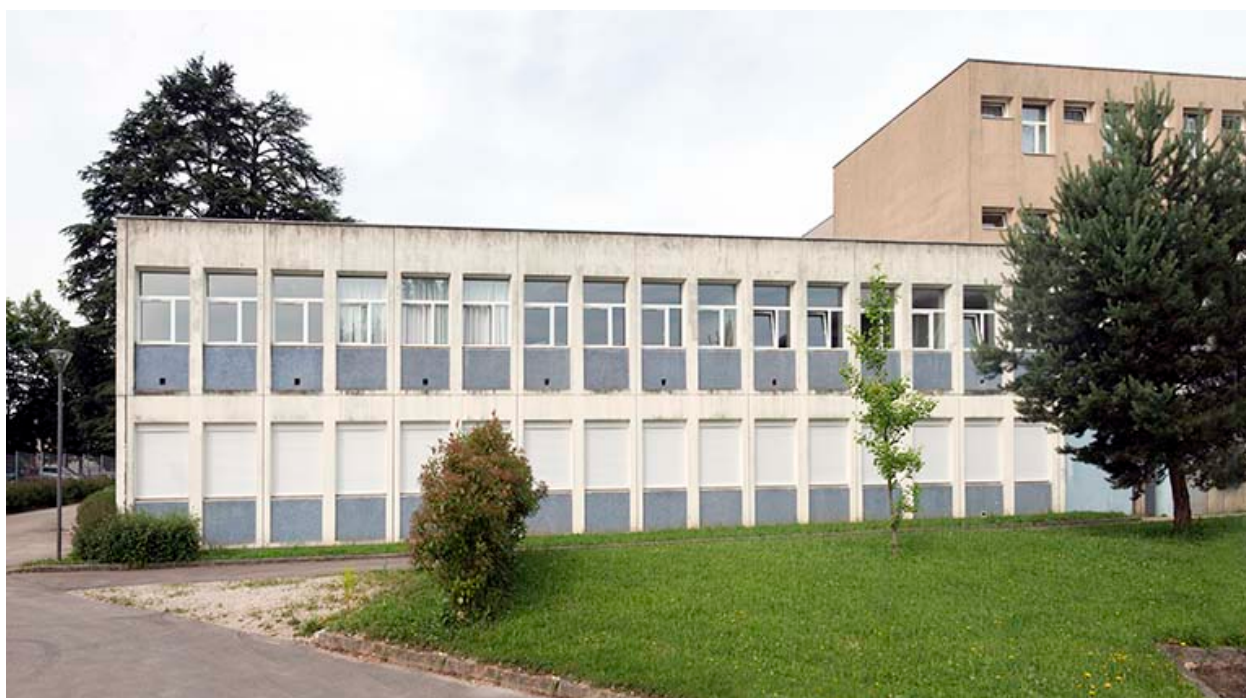
Façade nord-est du bâtiment d'internat et restauration.
