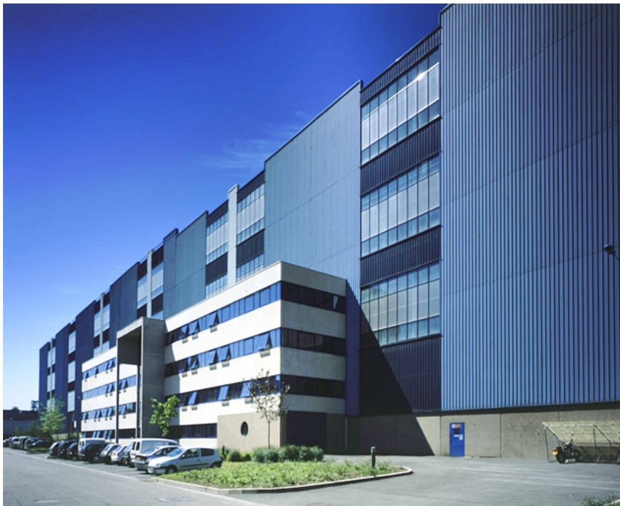
Halle 330 (bureaux et ateliers de montage).
