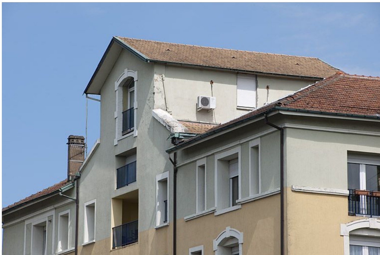
Partie supérieure de la façade postérieure.
