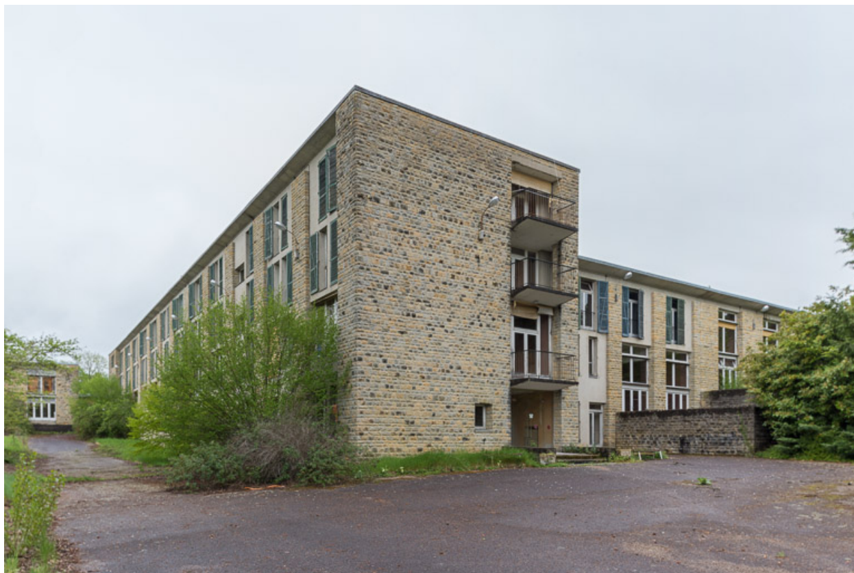
Élévation extérieure du corps de bâtiment principal.
