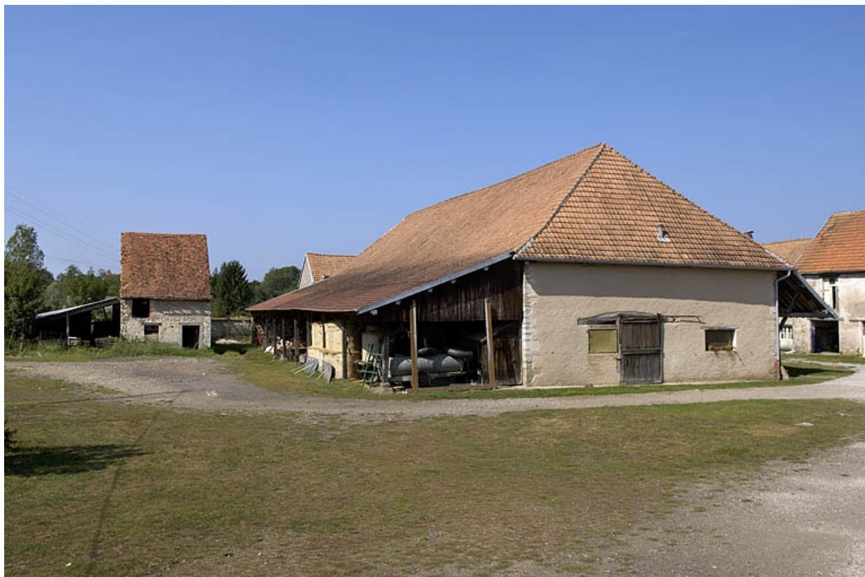
Vue depuis le sud-ouest de la cour.
