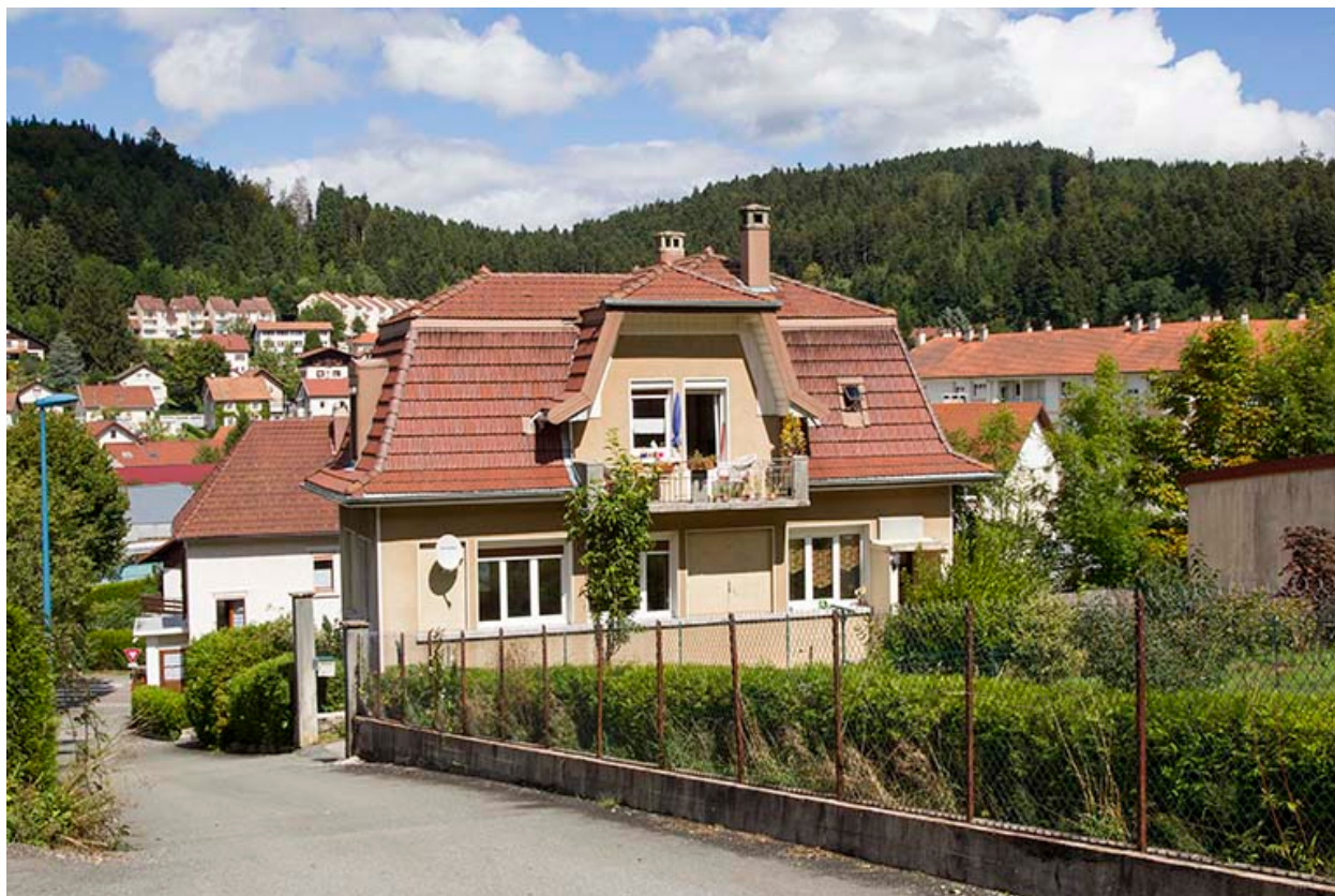
Façades postérieure et latérale droite.
