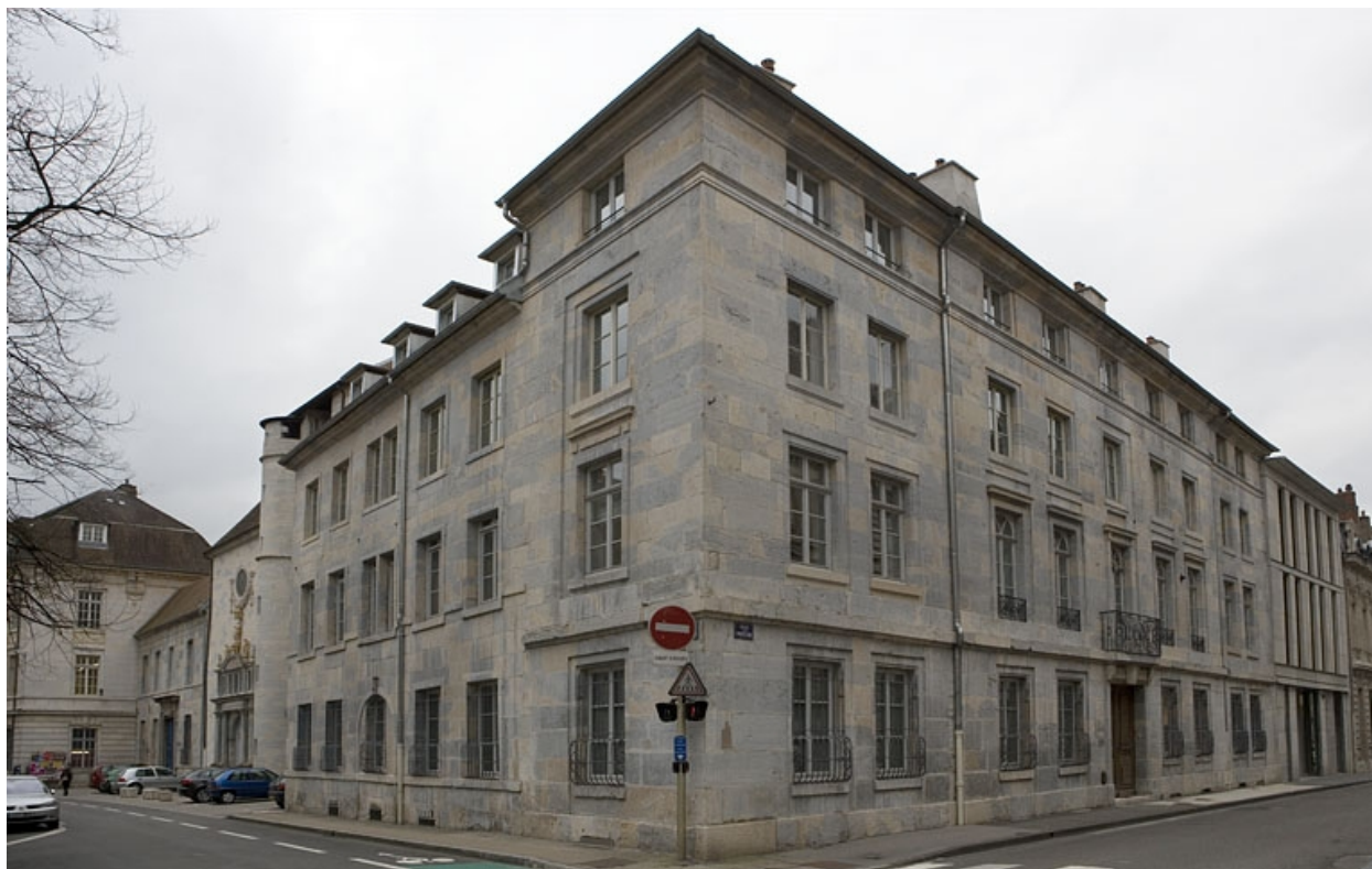
Vue d'angle de l'immeuble.
