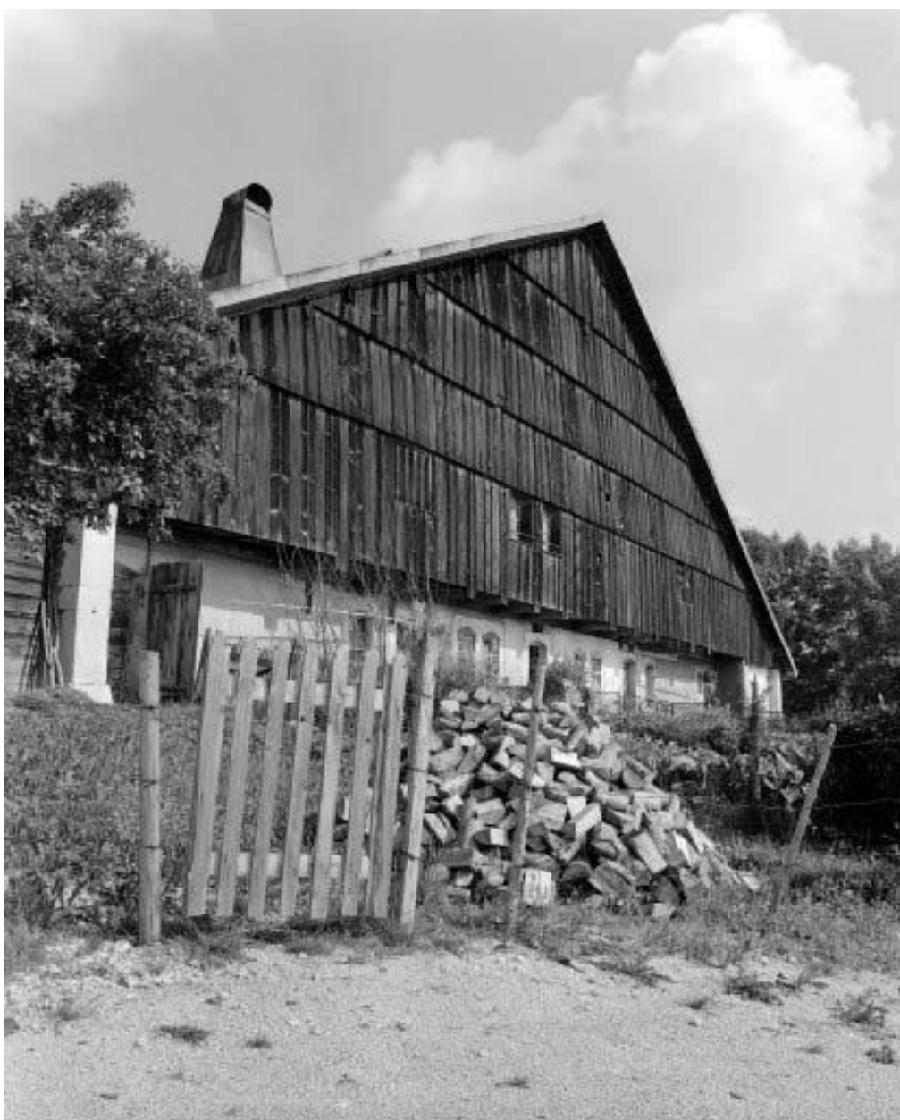
Pignon habitation vu de trois quarts gauche.
