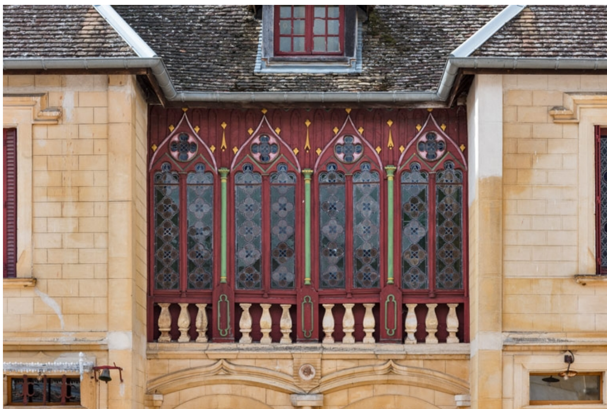
Elévation antérieure : galerie à l'étage.
