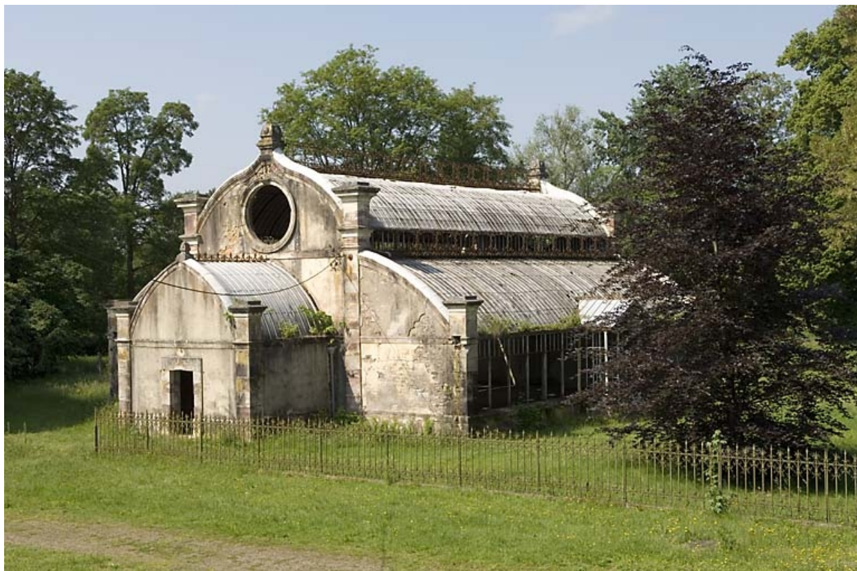
Vue d'ensemble de la serre.
