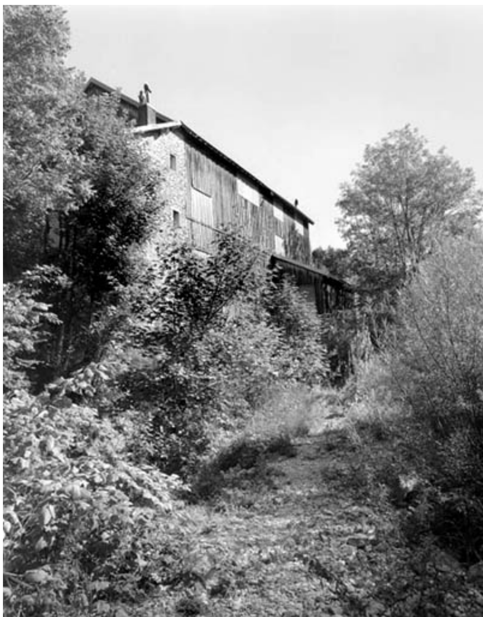
Façade sur l'Ain de l'atelier de fabrication.
