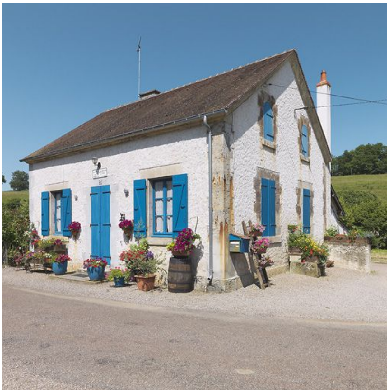
Vue de la maison éclusière de 3/4.
