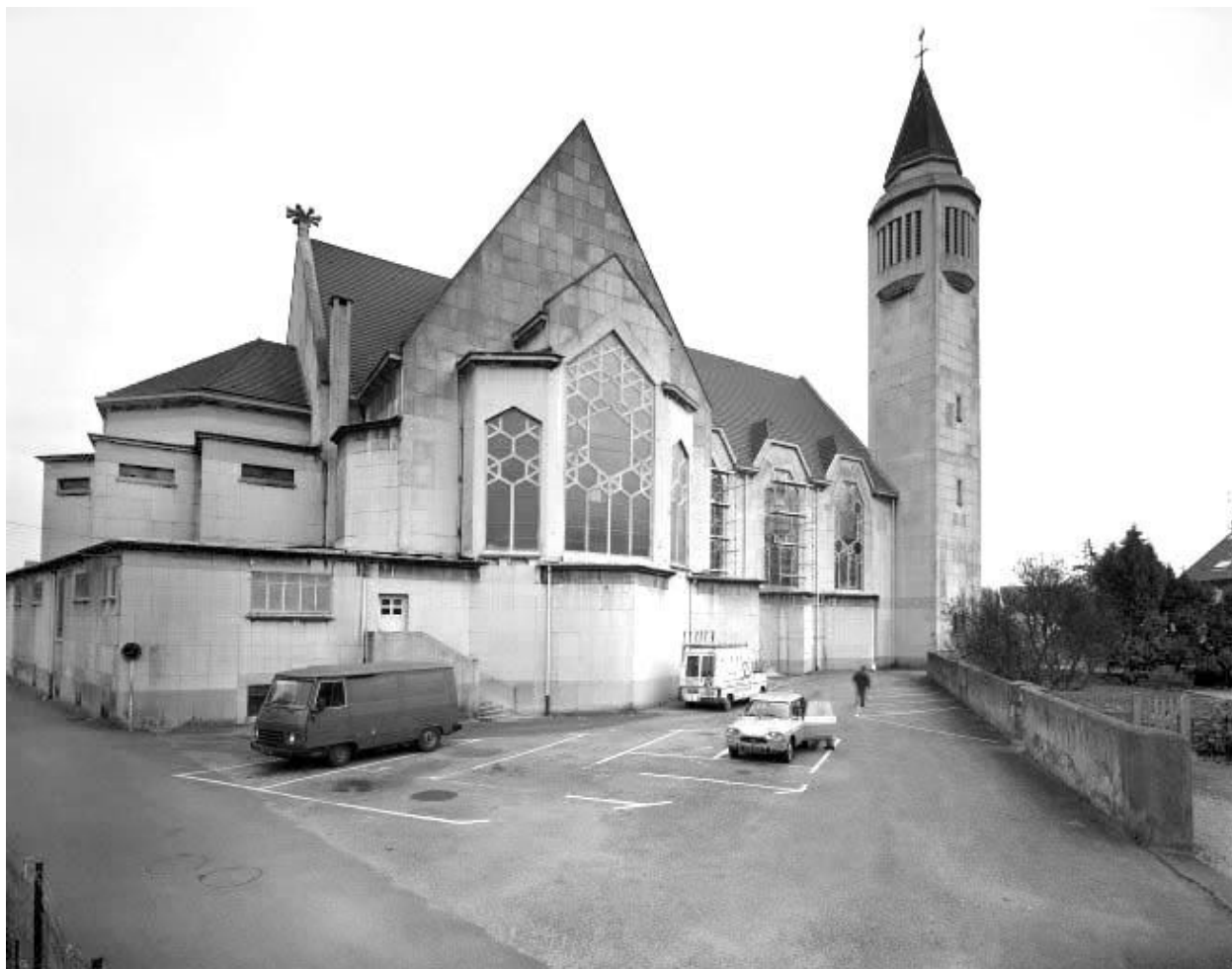
Chevet et façade latérale gauche.
