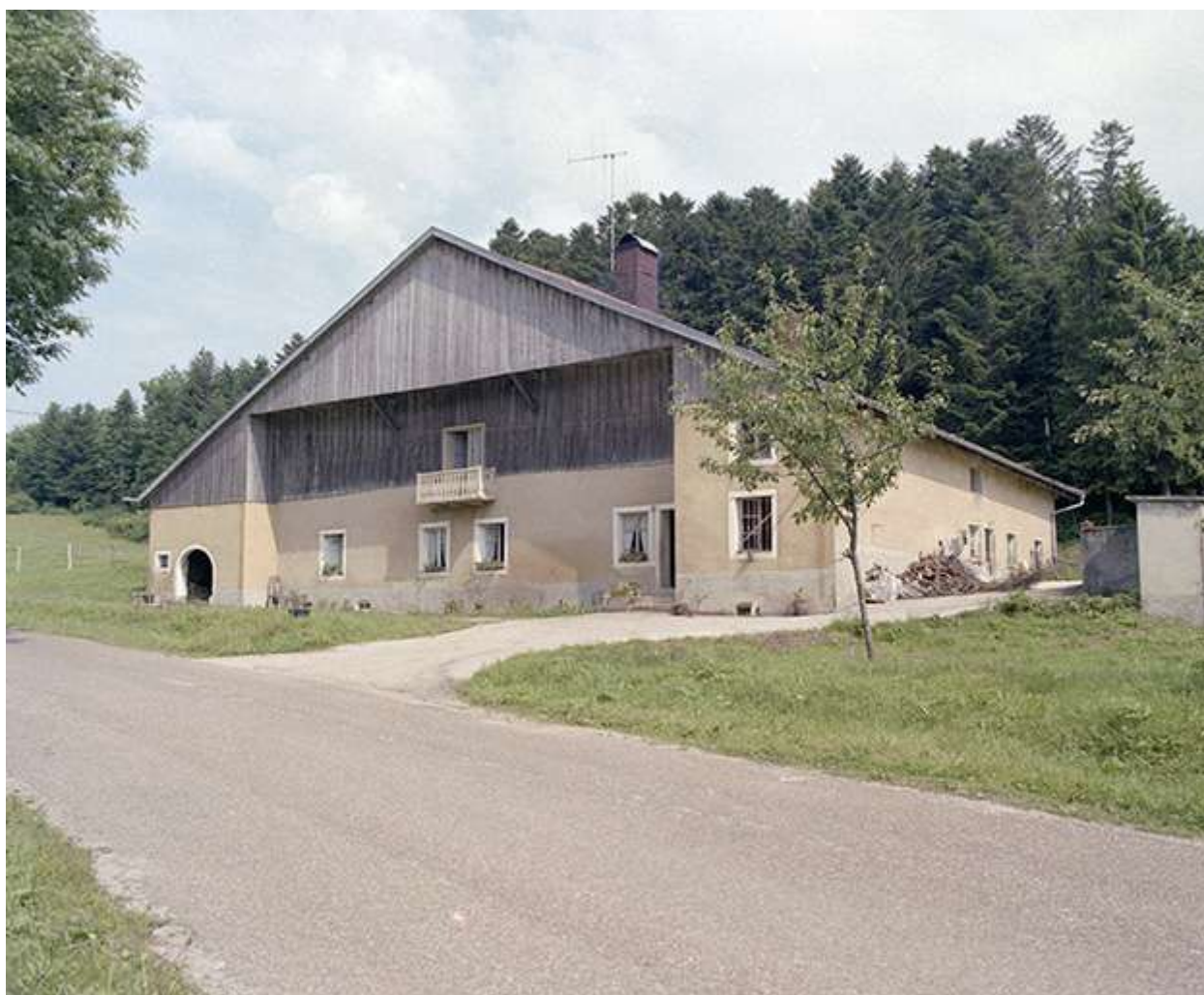
Ferme située au lieudit Les Cordiers.
