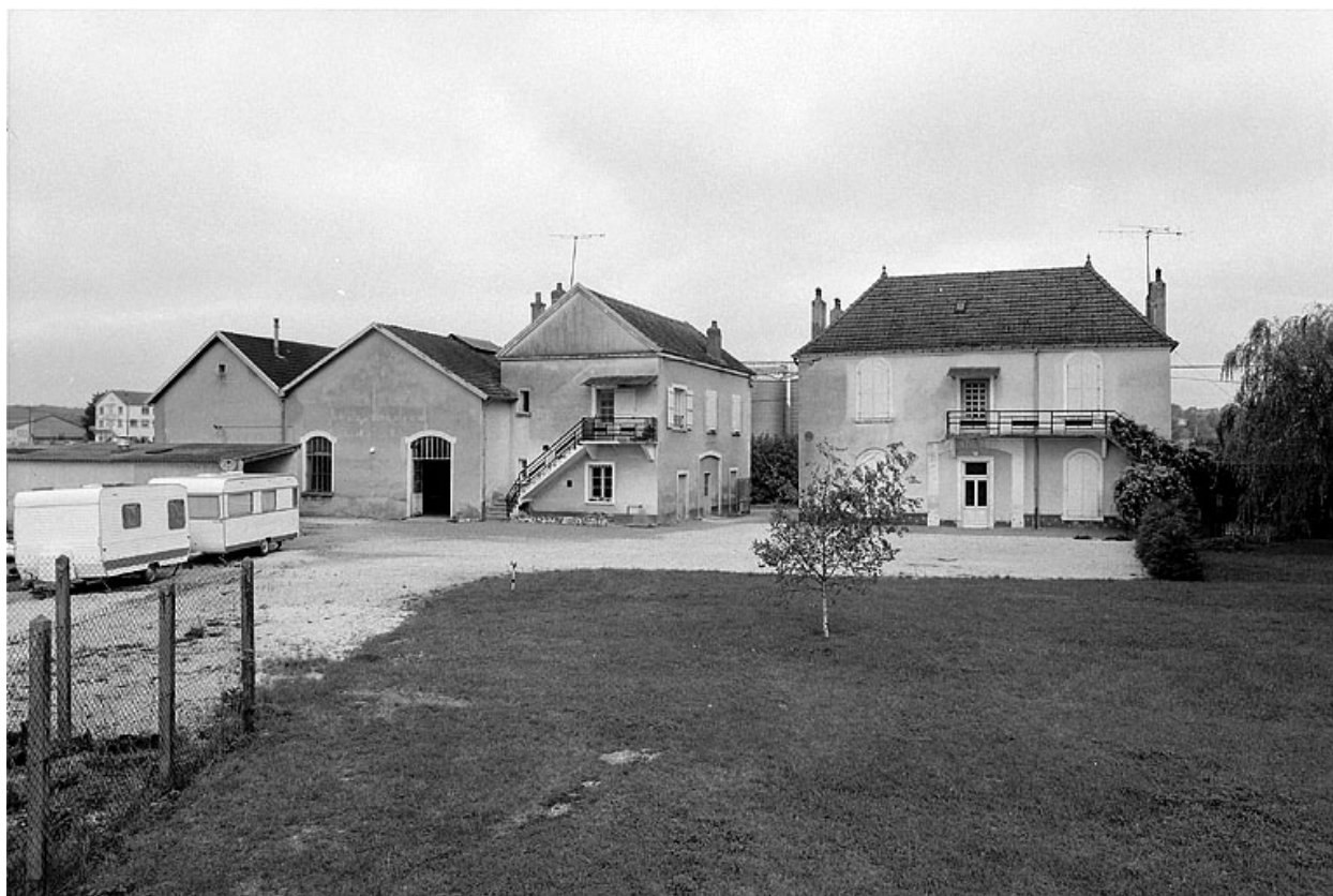
L'usine à gaz : façades postérieures.
