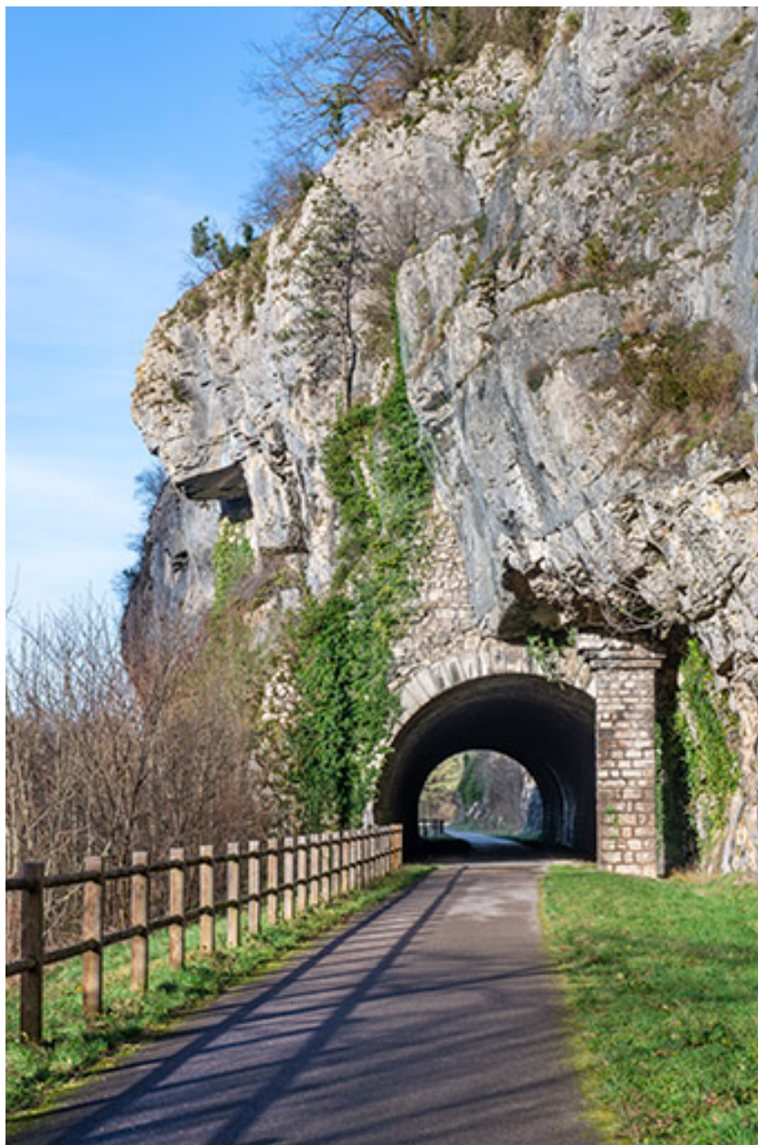
Vue du tunnel depuis l'est.
