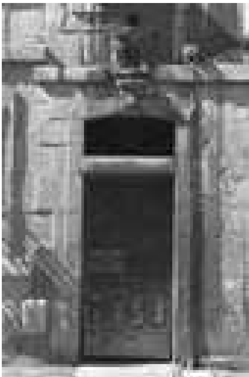
Immeuble : détail de la porte d'entrée.
