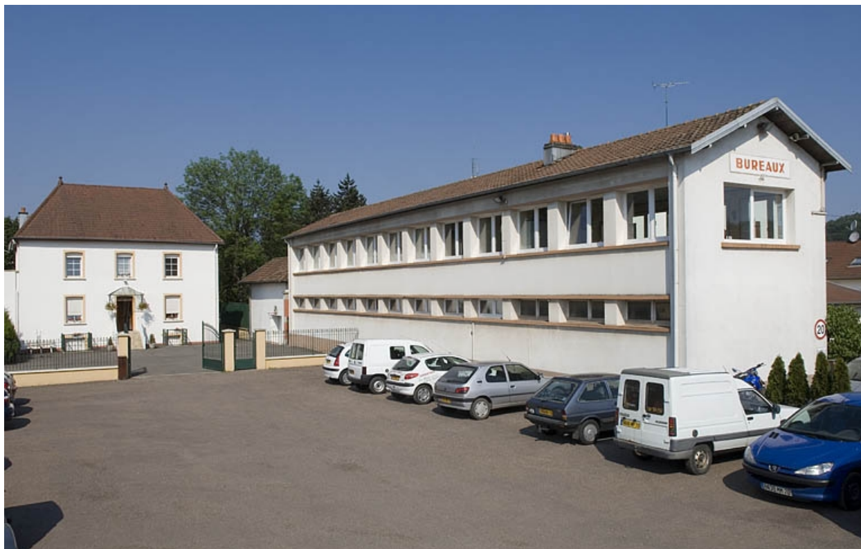
Logement patronal et bureaux.
