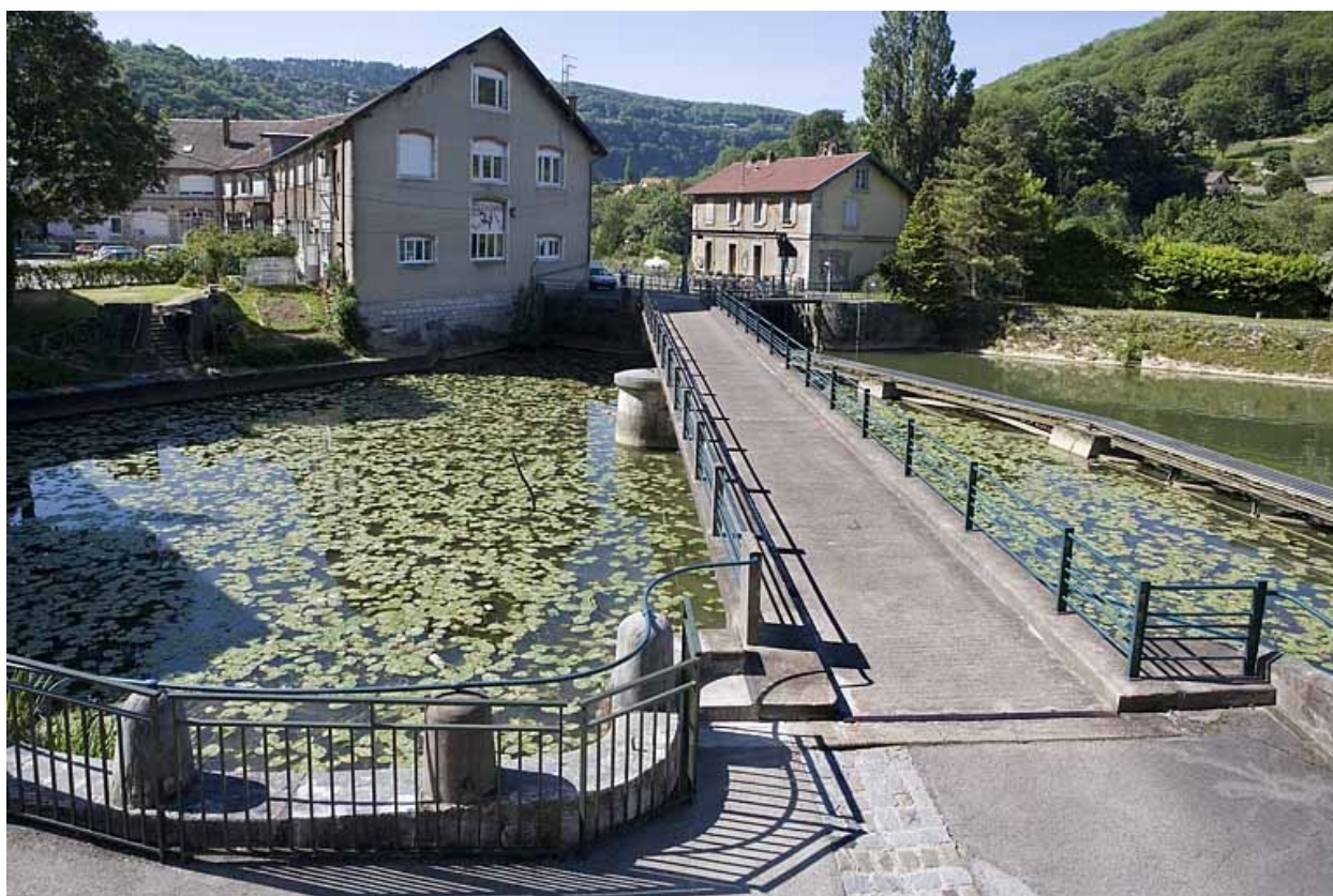
Vue d'ensemble, depuis l'amont.
