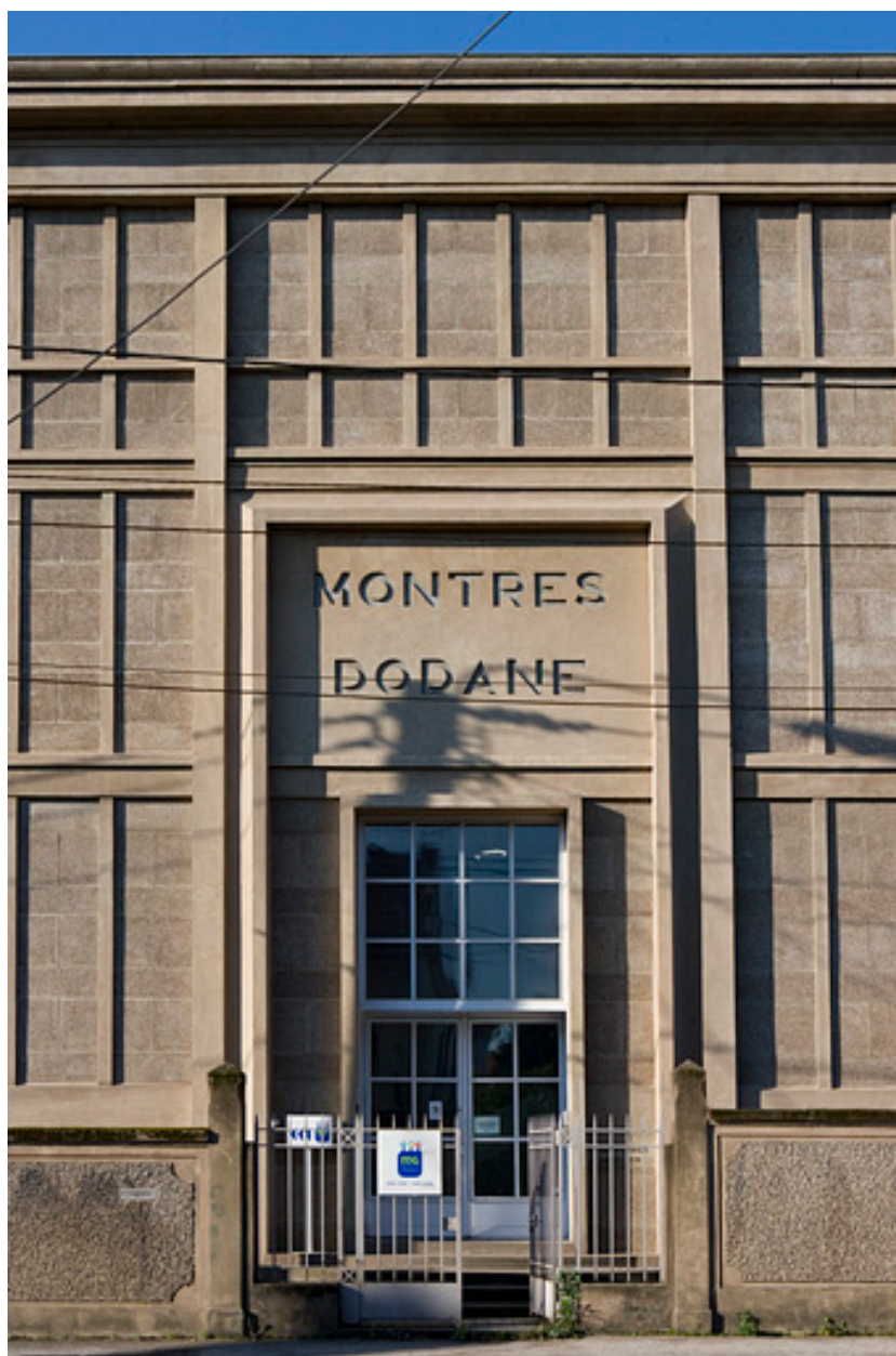
Façade antérieure : travée centrale.
