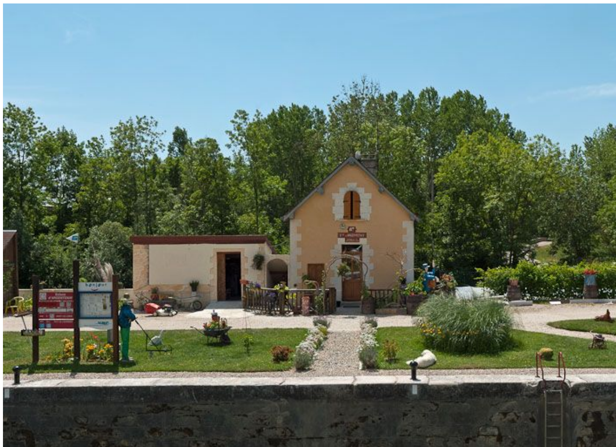
Vue d'ensemble du site d'écluse.
