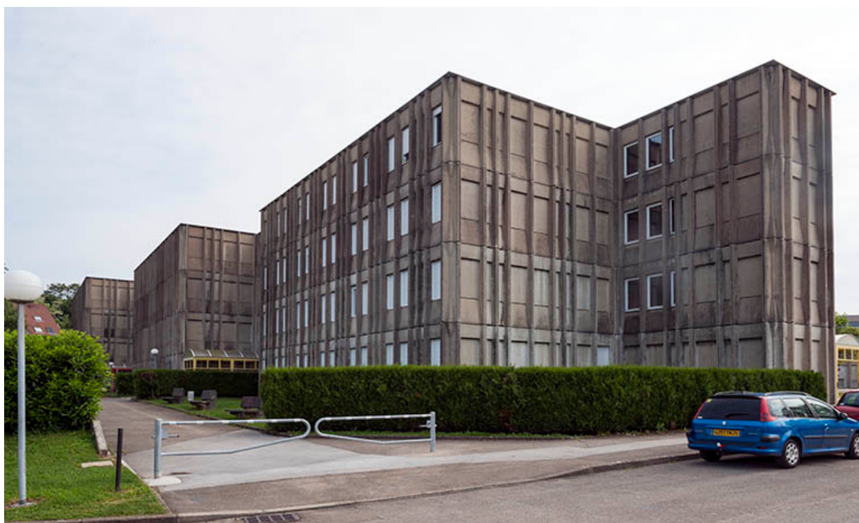
Façade ouest postérieure de l'internat.
