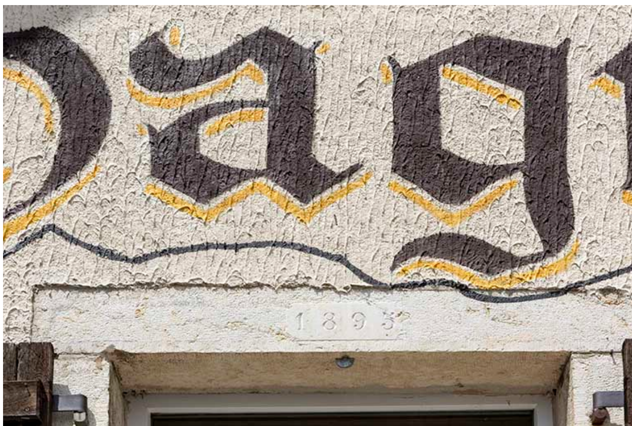
Façade antérieure : linteau daté 1895.
