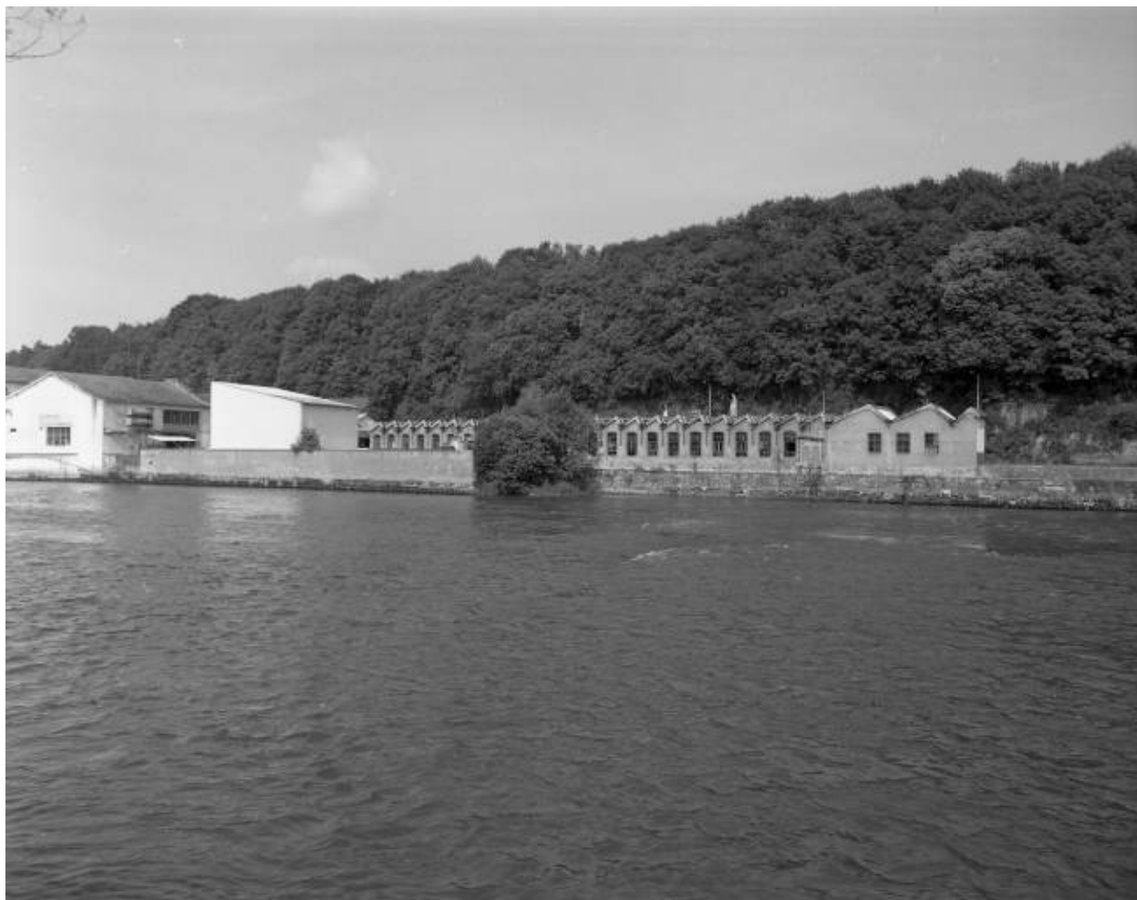
Vue générale depuis la rive droite.
