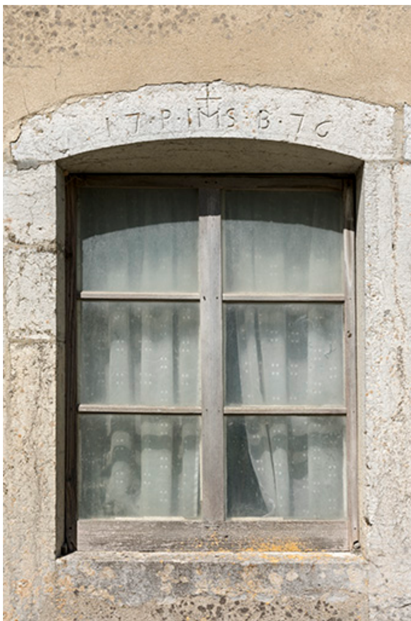
Façade est : fenêtre avec linteau daté 1776.
