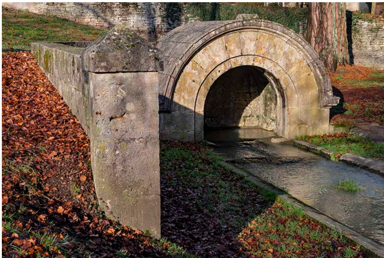
Mur de soutènement, vue depuis le sud.
