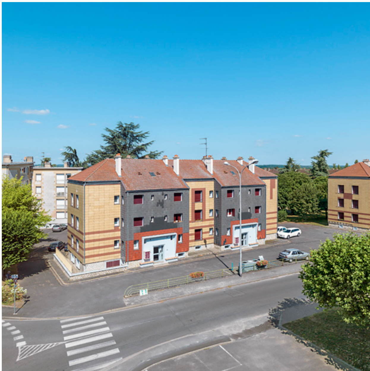
Bâtiment Binot-D, façade antérieure est.
