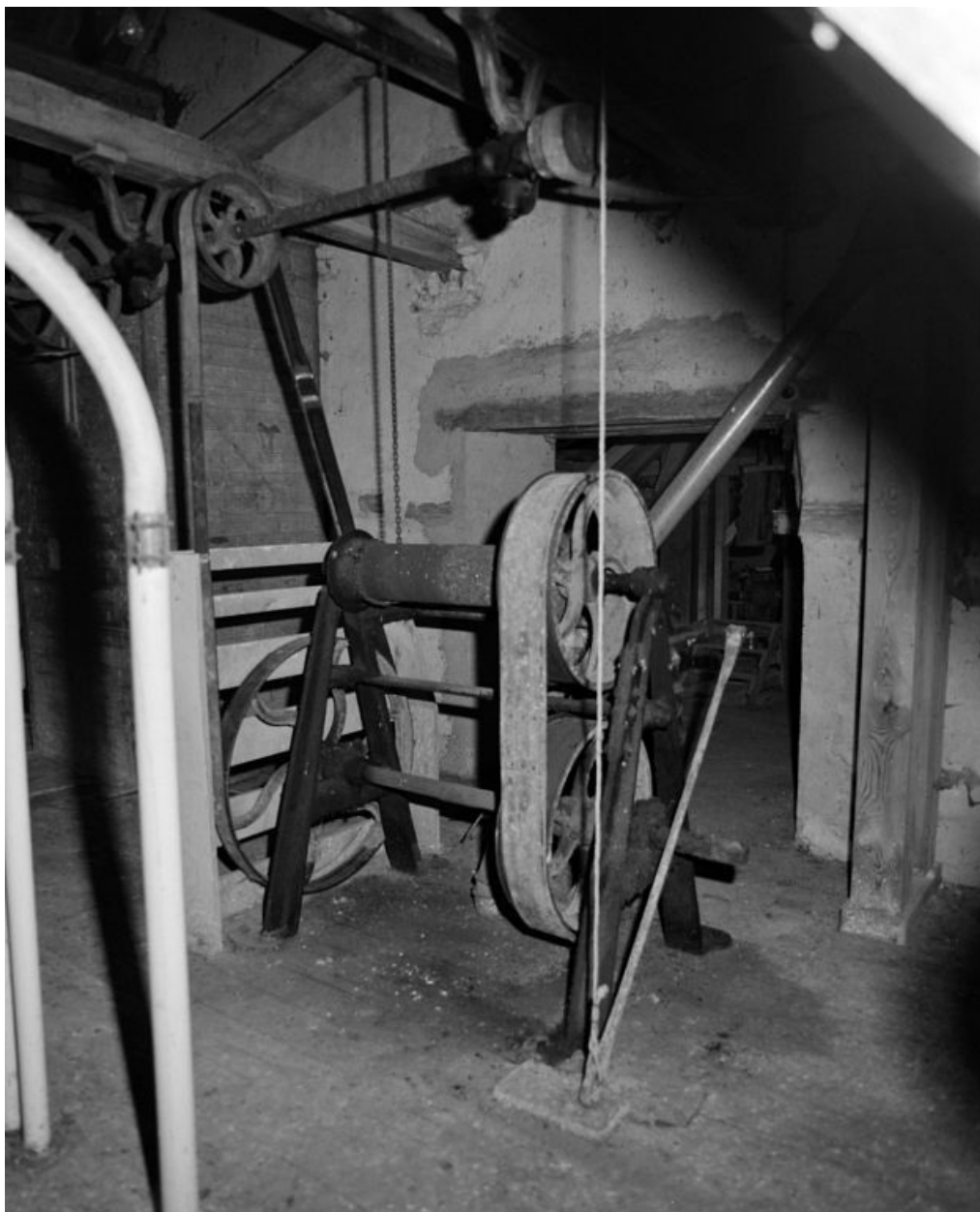
Comble à surcroît. Monte-sacs.
