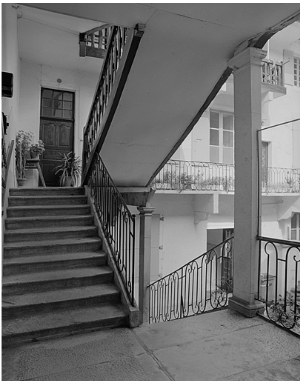
Escalier vu depuis le premier palier.
