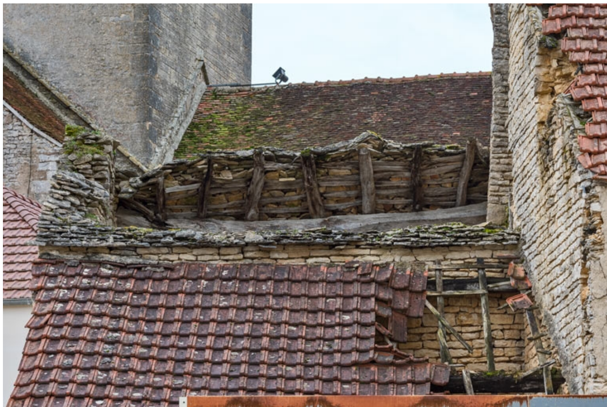
Détail de la toiture côté est.
