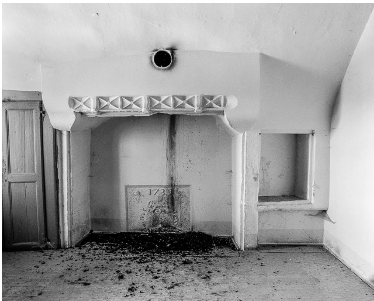
Corps de logis, cheminée.
