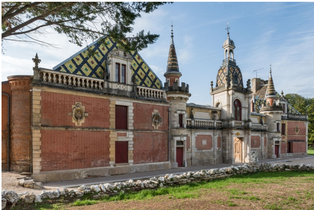
Elévation antérieure, de trois quarts gauche.
