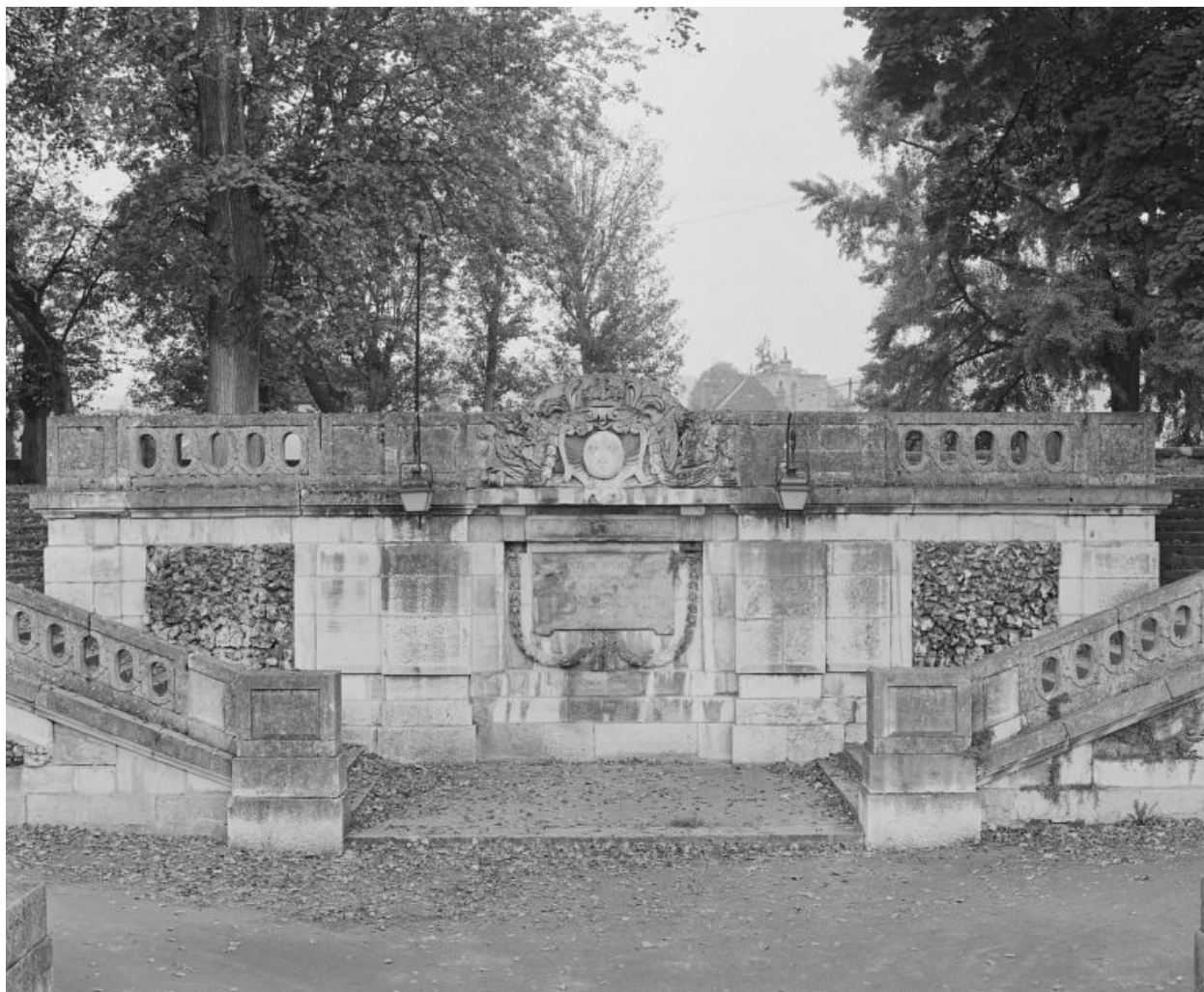
Vue de détail de l'escalier, de face (1988).
