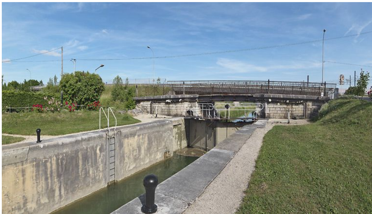
Le sas avec le pont vu d'amont.
