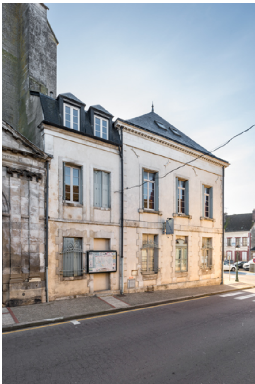
Façade latérale gauche, de trois quarts droite.
