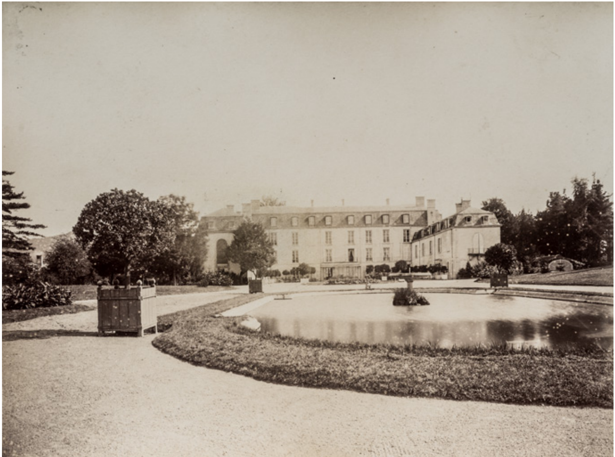
Bassin et vue sur la cour.
