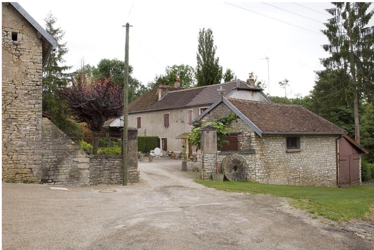
Vue d'ensemble depuis la rue.
