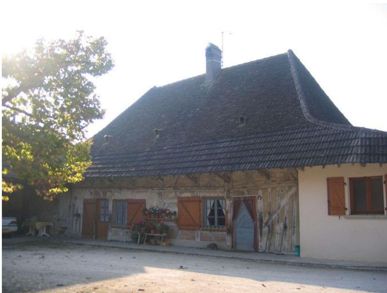
Vue d'ensemble de la façade de l'habitation.
