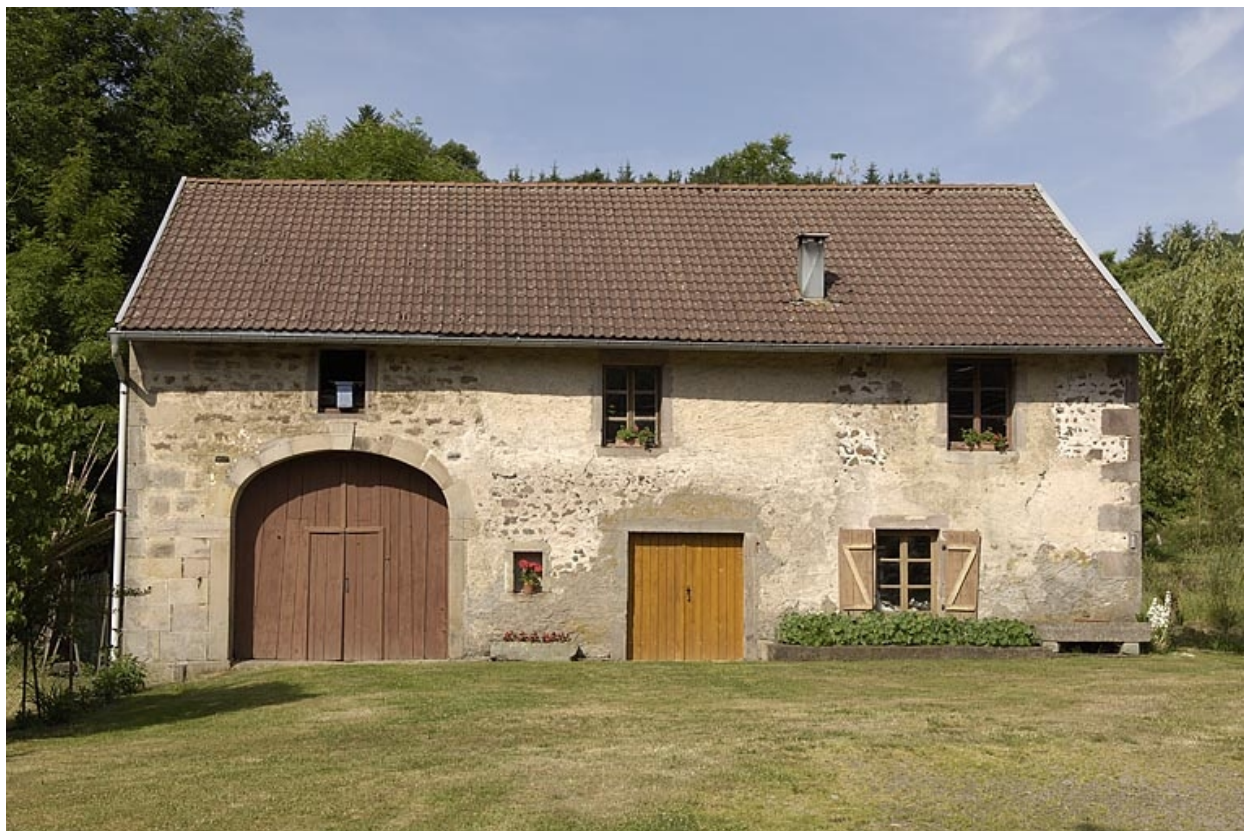
Façade est du moulin.
