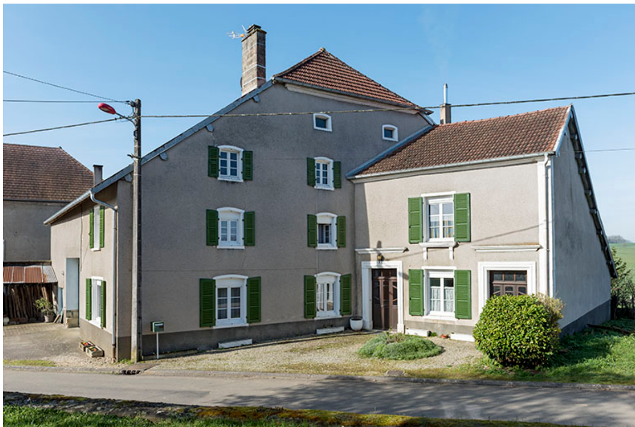
Maison ferme 23 Grande rue.
