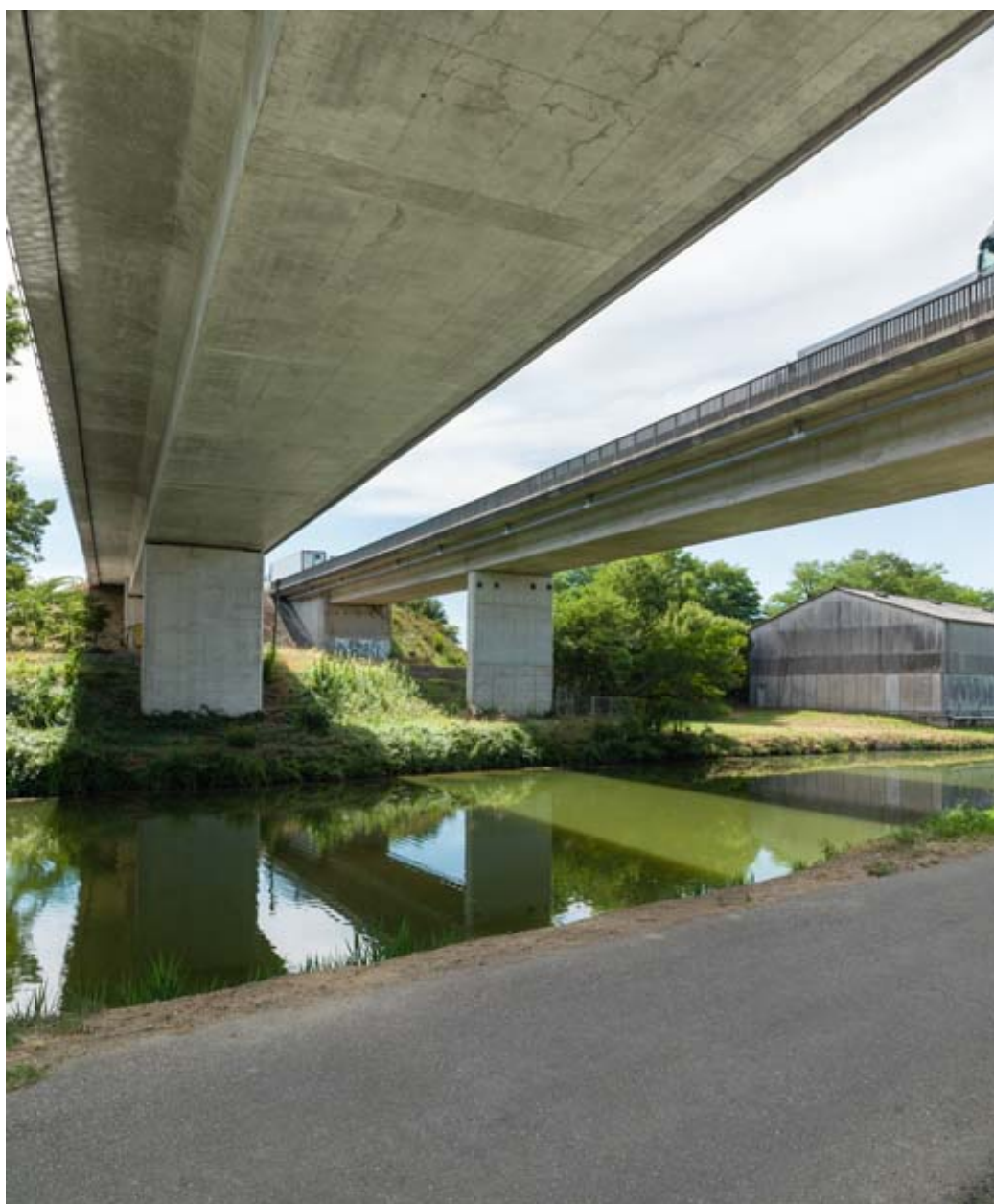
Vue rapprochée du pont.
