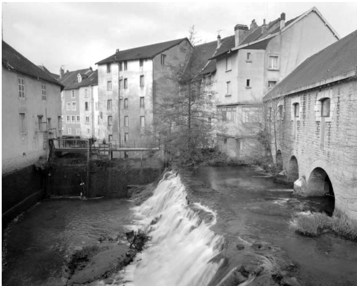
Le bassin de retenue vidé.
